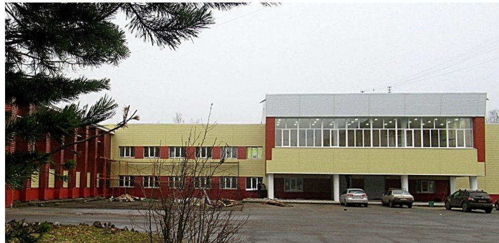
Капитальный ремонт Дома офицеров в п. Федотово Вологодского района
